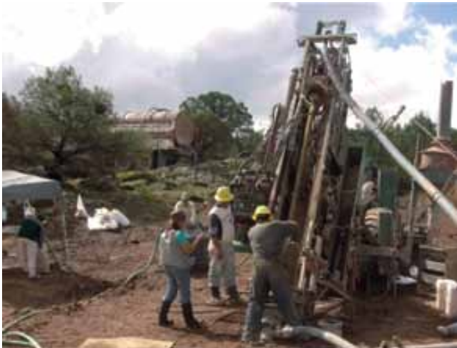
Figura 4. Maquinaria utilizada en la perforación durante la exploración.
